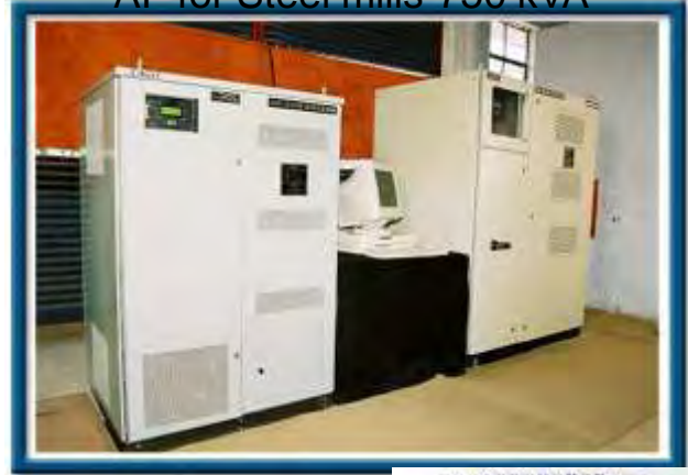
AF for Steel mills-750 kVA
